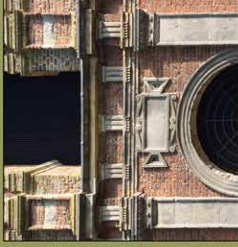
Rij triglifelen (een met twee helle en twee halve verticale pleuven versierde stenen plaat) boven het eerste vierkant van de toren. (foto uit 2008).
